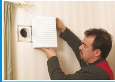
Laite painetaan kiinni asennuskehykseen, jolloin se samalla tiivistyy seinäpintaa vasten, liitosta ulkoilmaputkeen ei tarvita. Sähkökytkentä voi olla kiinteä tai pistotulppakytkentä.
