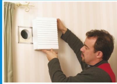
Intagsluftanläggningen trycks mot installeringsramen, där den samtidigt lägger sig tätt mot väggytan och ingen anslutning till luftintagsröret behövs. Elanslutning antingen fast eller med stickpropp.
