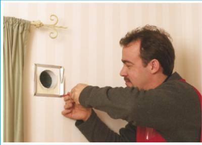
Efter att luftintagsröret och yttergallret installerats fästs installeringsramen på innerväggen. Om öppningen är större än anläggningen kan en underlagsskiva installeras.
