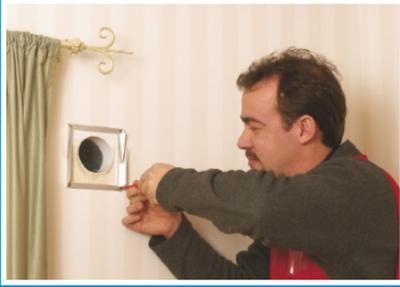
Kun ulkoilmaputki ja ulkosäleikkö on asennettu paikoilleen, kiinnitetään asennuskehys seinään. Mikäli aukko on suurempi kuin laite, käytetään aluslevyä.
