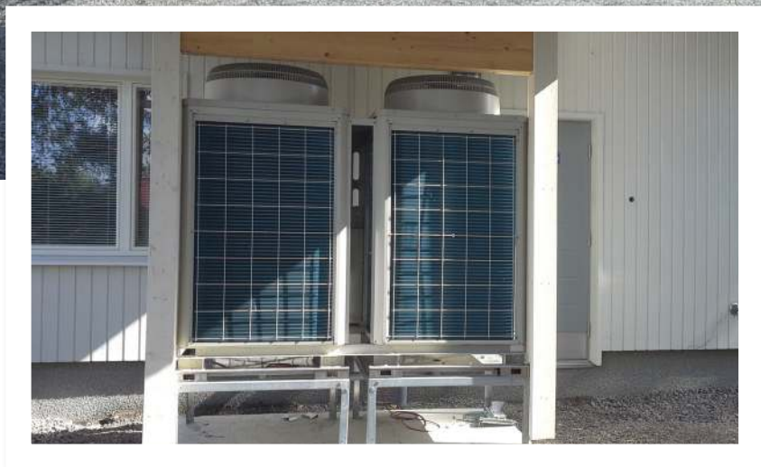
Mitsubishi Electric CAHV-P500 ilma-vesilämpöpumppu, lämpöteho 63 kW
